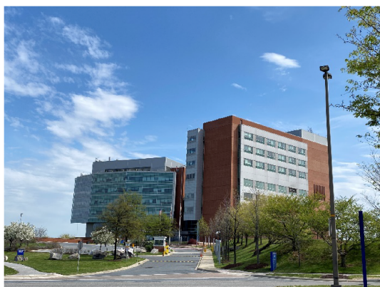
写真1 NIDA と NIA の基礎研究棟
