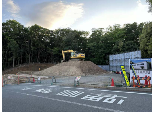
現在建設中の神経分子機能解析施設。年末には建物が完成し、2階に移転する予定です。
