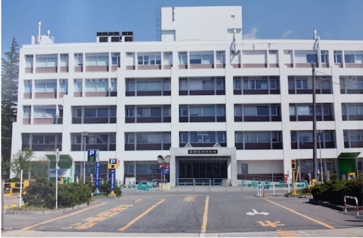
写真1 基礎医学研究棟
